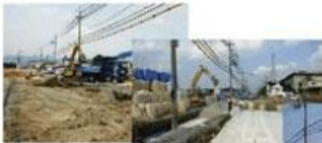
スーパーソール投入前
