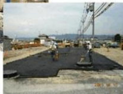
◆ 道路舗設状況
